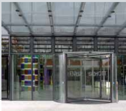
Schott AG | MAINZ | J • S • K Architekten | Typ GGG | vollautomatisch | 4-flügelig | edelstahlbeplankt | Nachtverschluss | Unterflurtrieb
