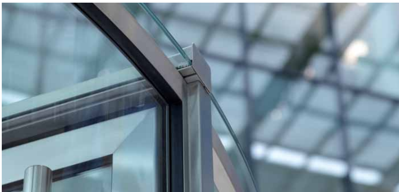
Schott AG | MAINZ | J • S • K Architekten | Typ GGG | vollautomatisch | 4-flügelig | edelstahlbeplankt | Nachtverschluss | Unterflurtrieb
