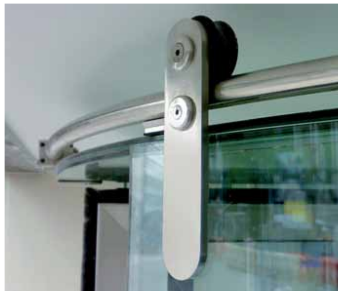
Nachtverschluss außen liegend – Glasflügel mit Punkthaltern
