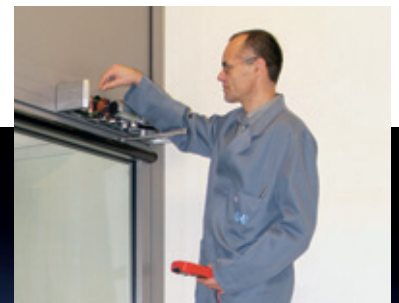
Service en onderhoud
